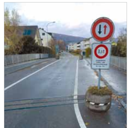
Die Hardbrücke führt über die Hauptstrasse.
